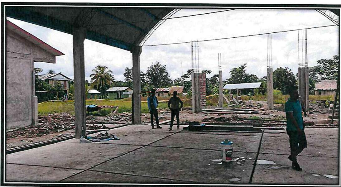
6.00 EN LA FOTO SE PUEDE APRECIAR LA CONSTRUCCION DE PISOS DE MORTERO S/COLOR, E=2.5 CM BRUÑADO.
