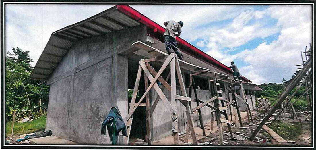
5.0 EN LA FOTO SE APRECIA LA COLOCACION CANALETAS DE PLANCHA GALVANIZADO DE EVACUACIÓN PLUVIAL Ø 8".
