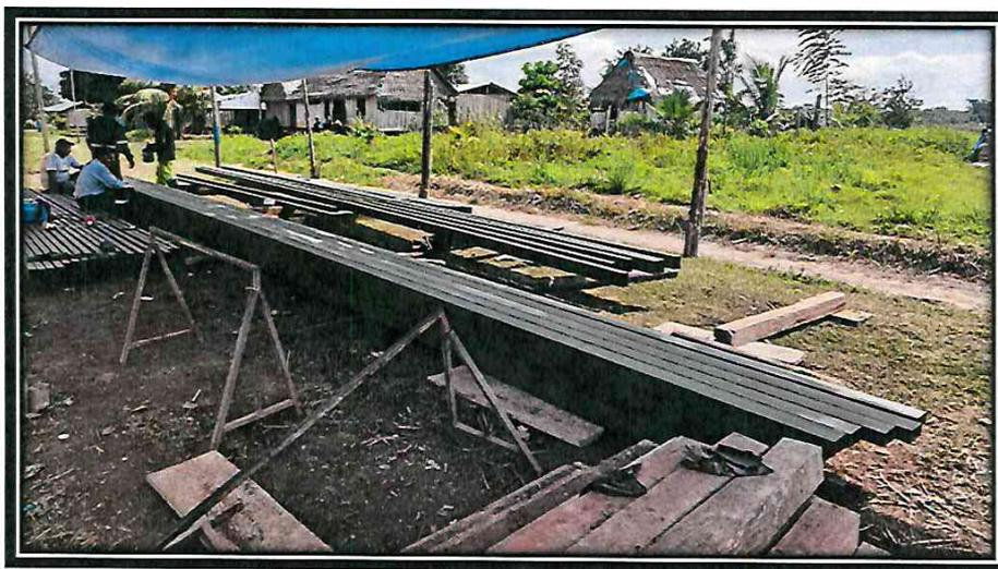
3.0 EN LA FOTO SE APRECIA LA HABILITACION DE LA ESTRUCTURA METALICA PARA LA ARMADURA DEL TECHO EN EL MODULO LOSA DEPORTIVA.
