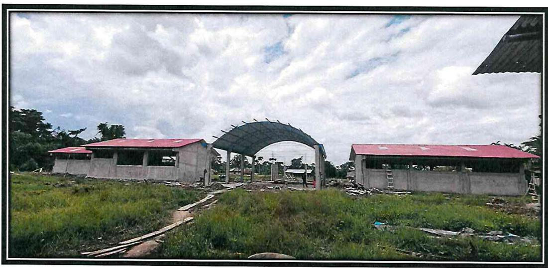
4.00 EN LA FOTO SE PUEDE APRECIAR LA COLOCACION DE CALAMINAS TRASLÚCIDAS EN LOS MODULOS AULA + SS.HH Y SUM COMEDOR.
