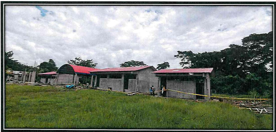
3.00 EN LA FOTO SE PUEDE APRECIAR LA COLOCACION DE COBERTURA DE CALAMINA ONDULADA ZINC 1.80M X 0.83M X 0.26 mm Y AL MISMO TIEMPO TRASLÚCIDAS EN LOS MODULOS AULA + SS.HH Y SUM COMEDOR.
