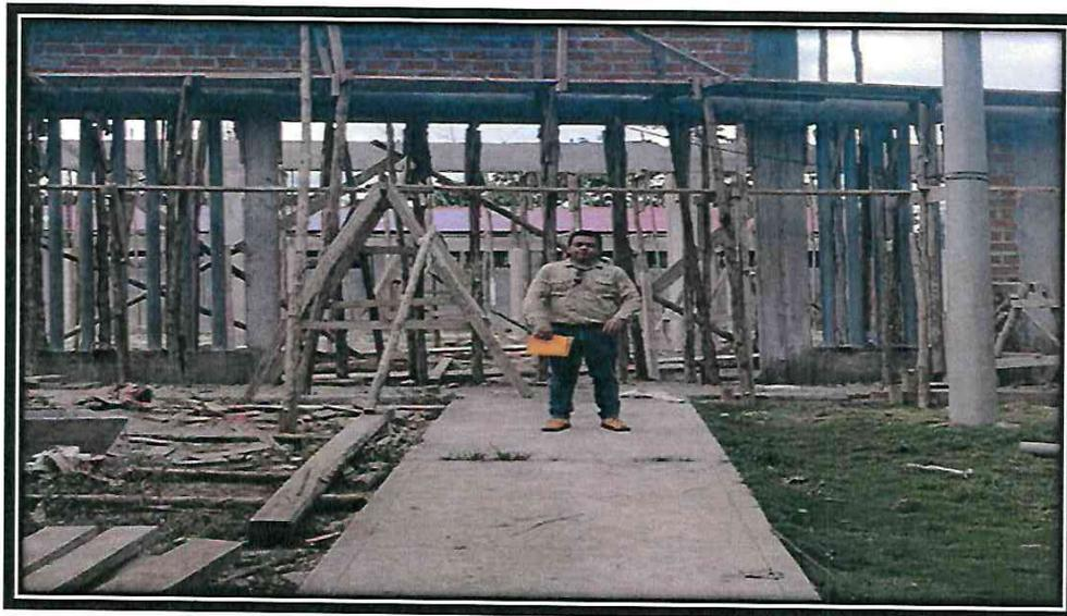
4.0 EN LA FOTO SE APRECIA LA CONSTRUCCION DE VEREDA DE ACCESOS DE MORTERO  $f'c= 175$  kg/cm<sup>2</sup> FROTACHADO DE  $e= 4''$
