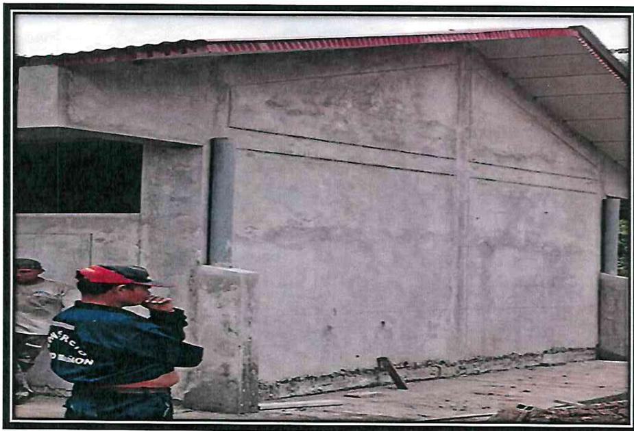
8.00 EN LA FOTO SE PUEDE APRECIAR LA CONSTRUCCION DE MURO PROTECTOR PARA TUBO DE BAJADA DE DRENAJE PLUVIAL  $h= 1.50 \text{ mts.}$  Y COLOCACION DE TUBERIA DE BAJADA DE AGUA DE LLUVIA PVC SAL  $\varnothing 4''$  (Inc. Codos PVC SAL), EN LOS DIFERENTES MODULOS.
