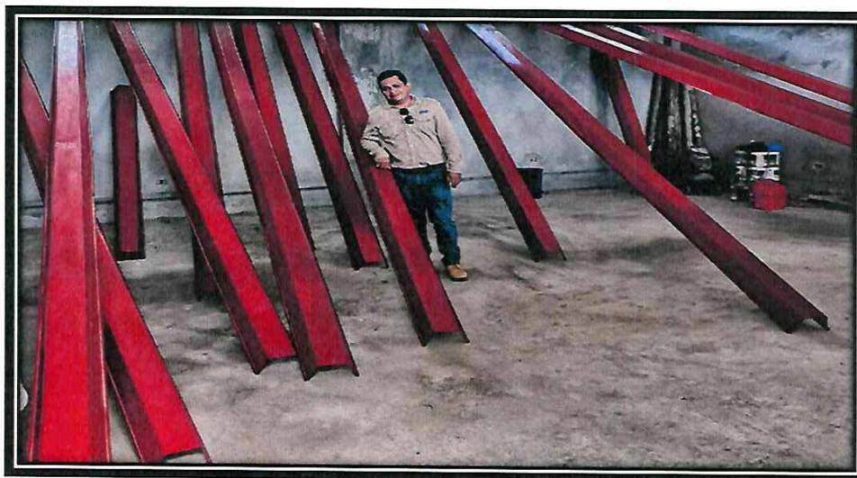
4.0 EN LA FOTO SE APRECIA LA HABILITACION DE LAS CORREA METALICA TIPO CANALES "U" DE 4" DEL TECHO EN EL MODULO LOSA DEPORTIVA.
