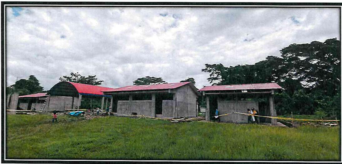
5.00 EN LA FOTO SE PUEDE APRECIAR LA COLOCACION DE CUMBRERA DE CALAMINA ONDULADA ZINC DE 0.26mm EN TODOS LOS MODULOS.
