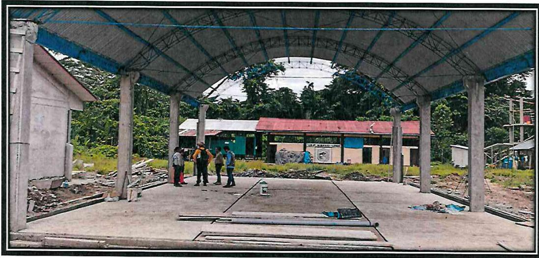
2.00 EN LA FOTO SE APRECIA EL TECHADO DE LA COBERTURA CON FIBRA VEGETAL +BITUMEN ASFALTICO Y CANALETA METALICA EN EL MODULO PATIO DE FORMACION.
